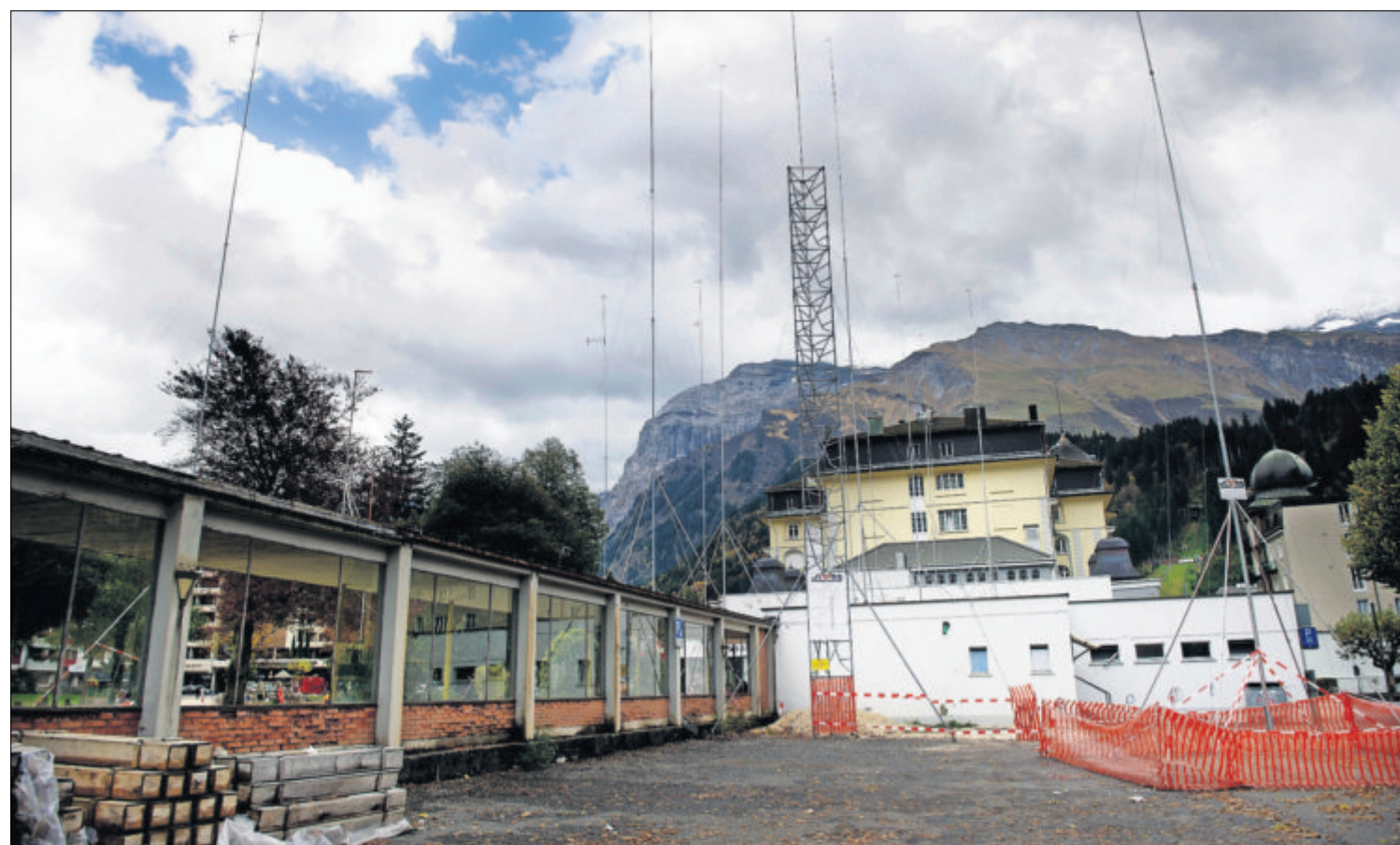
Hotelprojekt in Engelberg: Das Baugespann zeigt die Dimensionen auf. Bild Corinne Glanzmann
